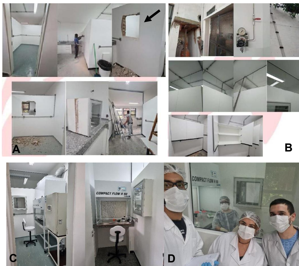
Figura 1 –Laboratório de Cultivo Celular do Instituto de Pesca (LCC-IP). A – Fase inicial de adaptação das instalações, com colocação de divisórias e “Pass Through” (seta). B – Instalação das conexões para transmissão de gás CO 2 para alimentação das incubadoras e isolamento das áreas limpa e cinza. C – Fluxos laminares da área limpa e área cinza. D – Equipe do projeto.
