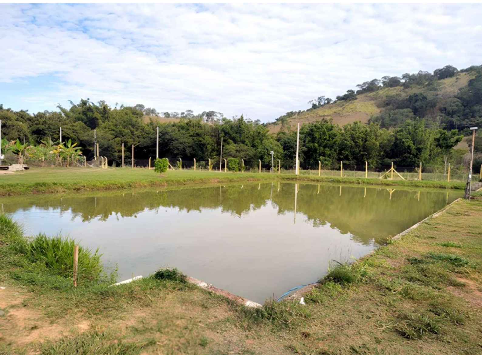
Figura 60: Viveiro escavado. Foto: Ismael Rafane, Vinicius Mendanha, Paula Fontes e Matheus Freire.
