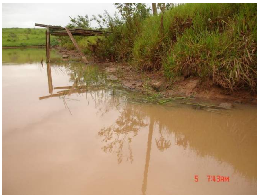
Figura 17. Talude da represa da Estação Ecológica evidenciando a redução do nível de água e elevada turbidez devido ao grande volume de material carregado durante impacto no córrego Morais ocorrido em janeiro de 2010.
