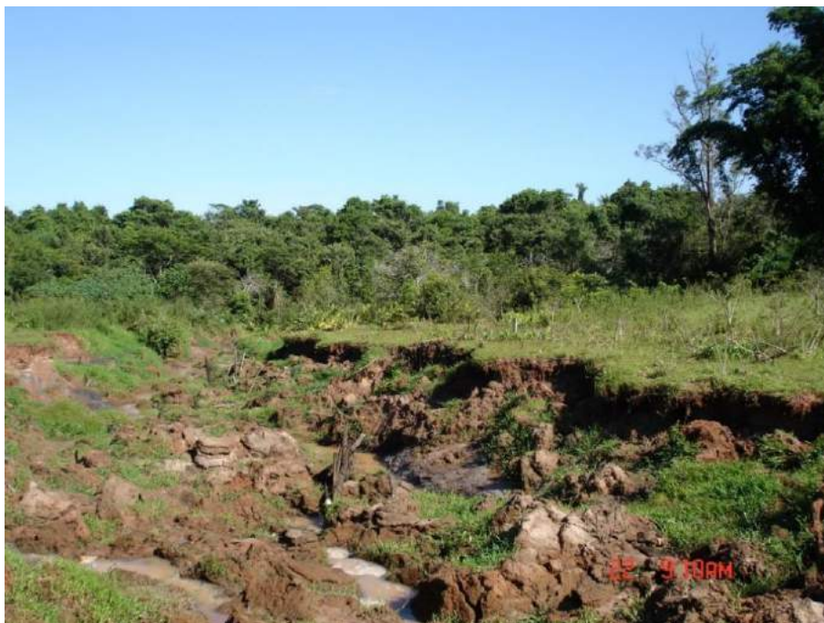
Figura 13. Impacto no córrego Morais ocorrido em janeiro de 2010 durante o início da implantação do condomínio. Trata-se do mesmo local do impacto detectado em janeiro de 2019, e onde o Instituto de Pesca realiza coleta de água.
