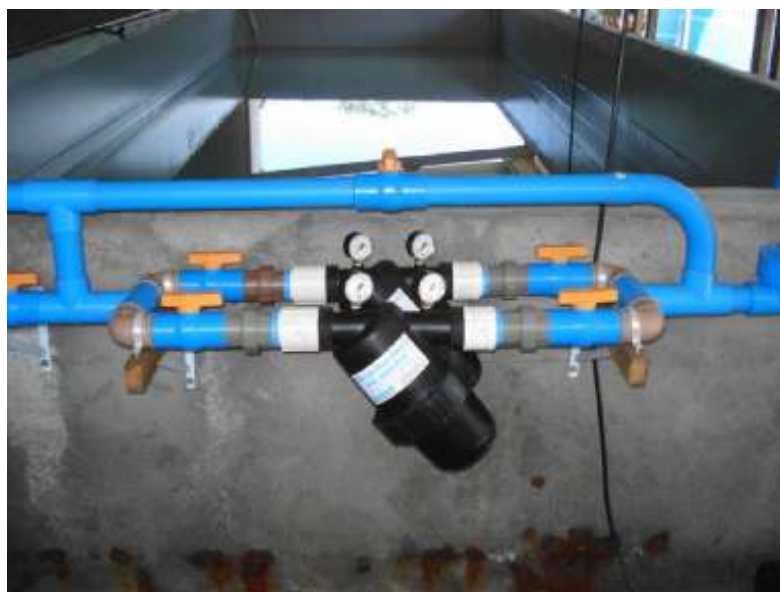
Figura 4. Filtros de disco (filtragem física). Fonte: Instituto de Pesca
