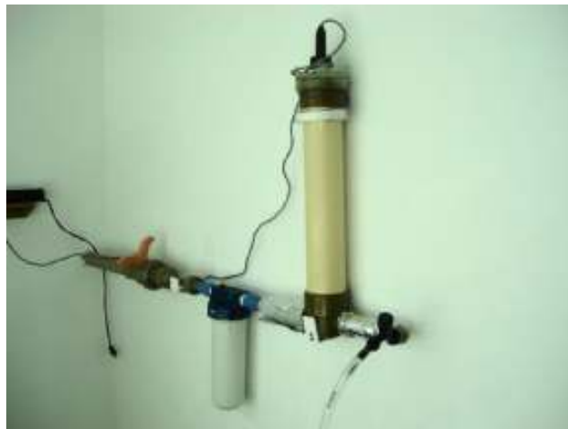
Figura 9. Sistema de esterilização com lâmpadas ultravioleta. Fonte: Instituto de Pesca
