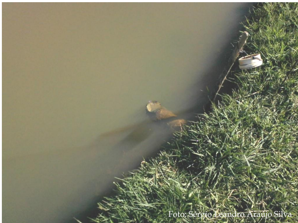
Figura 6: Detalhe do vertedouro de superfície, destacando o efluente do viveiro.
