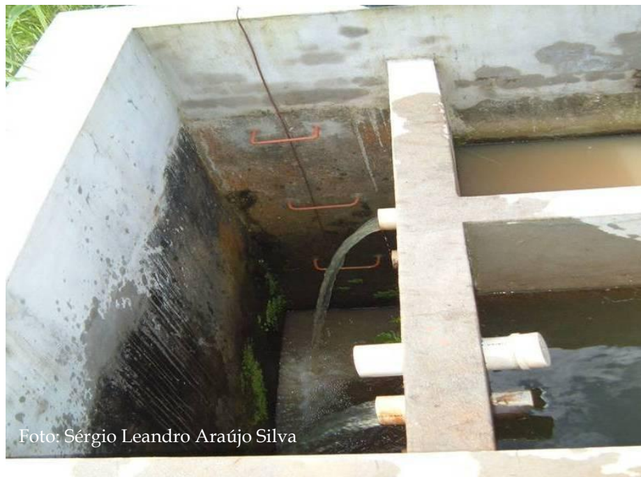
Figura 5: Detalhe do monge (vertedouro), destacando o efluente do viveiro.
