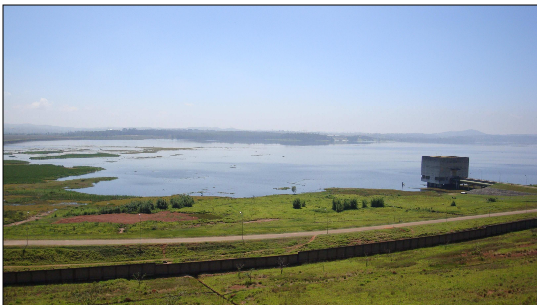
Foto 3. Visão detalhada da estação de captação de água e imagem geral do reservatório.
