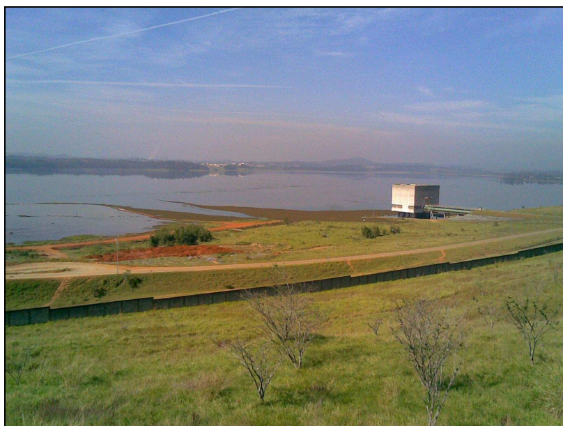
Foto 2. Imagem do reservatório de Taiapuêba, com visualização angular diferenciada da estação de captação de água.
