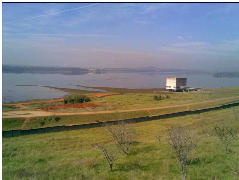
Foto 2. Imagem do reservatório de Taiapuêba, com visualização angular diferenciada da estação de captação de água.
