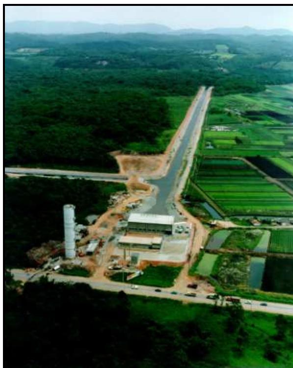
Figura 5. Tomada de água, interligação Tietê-Biritiba. Fonte: DAEE, 1999.
