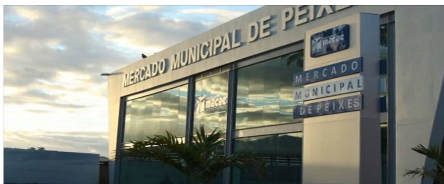
Figura 1. Vista externa do Mercado Municipal de Peixes de Macaé, RJ. (Arquivo pessoal, 2016)
