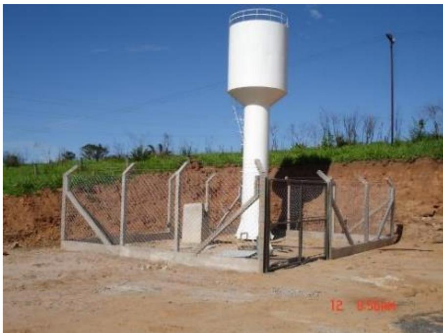
**Figura 17.** Poço artesiano com 100 m de profundidade, nível dinâmico de 33,46 m, nível estático de 25,08 m e vazão de exploração de 10,56 m<sup>3</sup> h<sup>-1</sup>.
