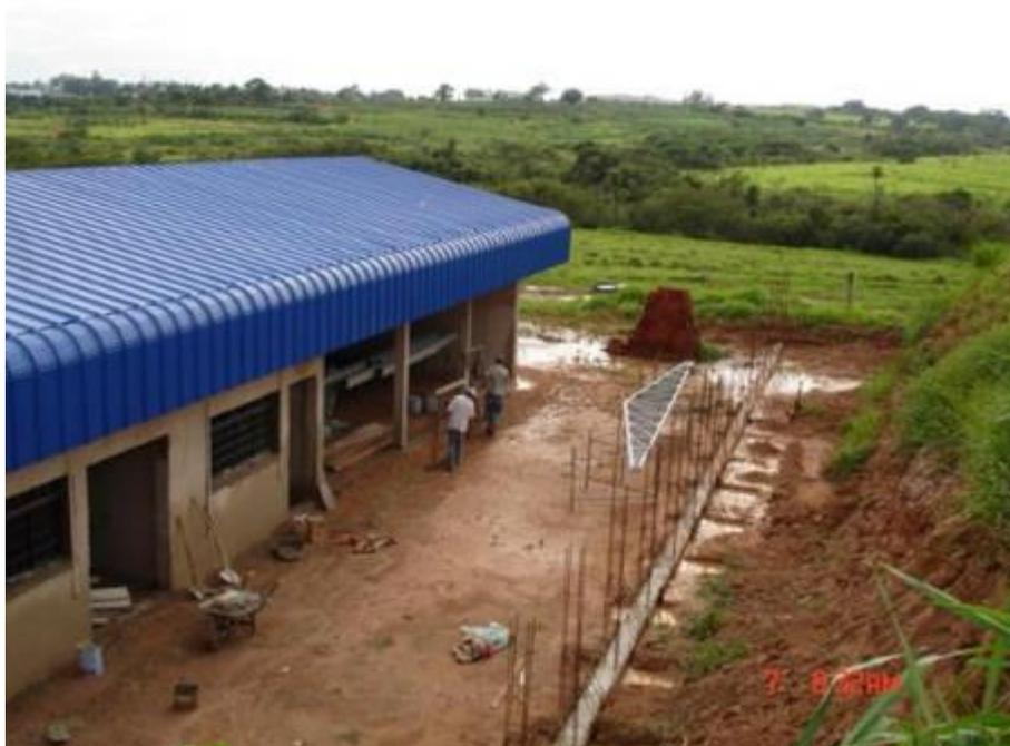
**Figura 31.** Construção da edificação de manutenção (200 m<sup>2</sup>), e do muro de arrimo entre as cotas 93 e 99 do Centro APTA do Pescado Continental, São José do Rio Preto, SP, em 2010.
