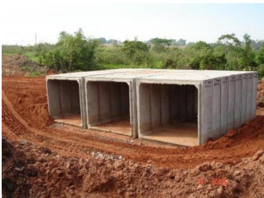
**Figura 38.** Instalação dos três canais de aduelas cada uma com 3,5 x 3,0 m sobre o córrego da Piedade.
