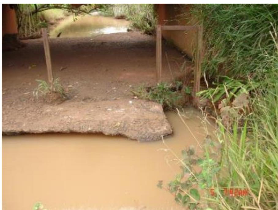
**Figura 11.** Vertedouro de superfície da represa parcialmente rompido devido ao aumento do escoamento superficial de águas pluviais, em 2010.
