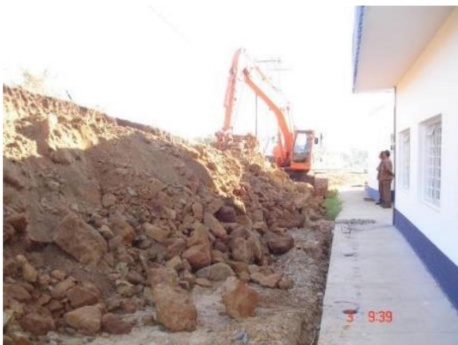
**Figura 41.** Diminuição do talude e alargamento do arruamento ao lado da ferrovia para colocação do piso intertravado.
