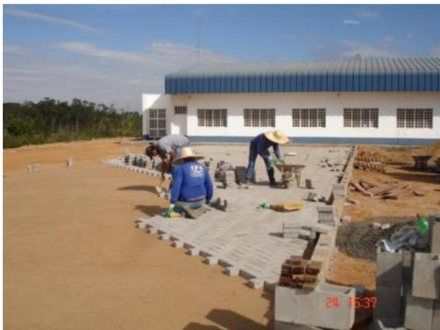
**Figura 43.** Colocação do piso intertravado na área da edificação de escritórios.
