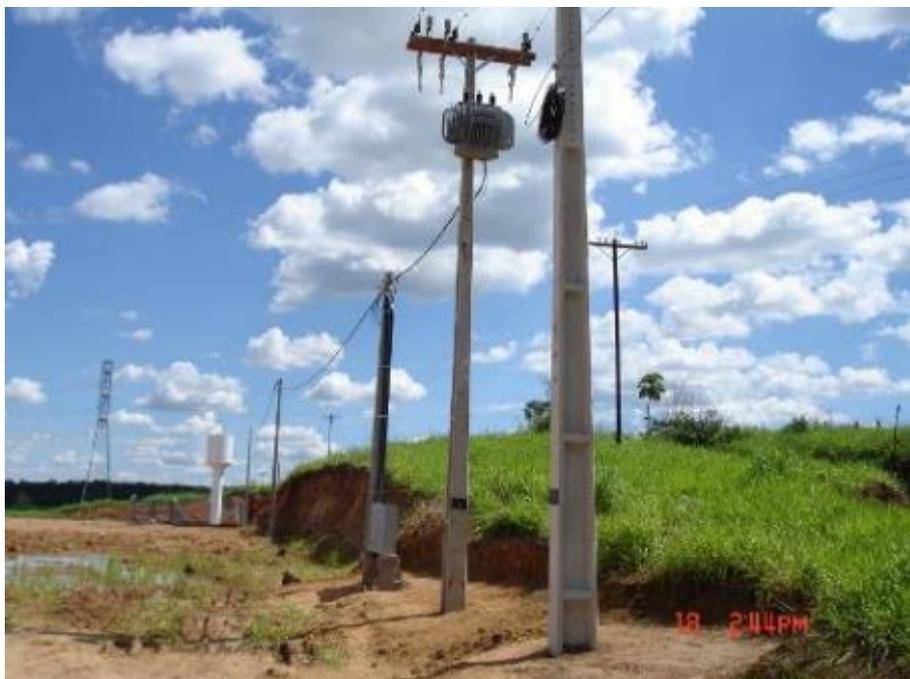
**Figura 16.** Rede elétrica para atendimento das demandas de energia das edificações a serem instaladas no platô, com transformador de 125 KVA.
