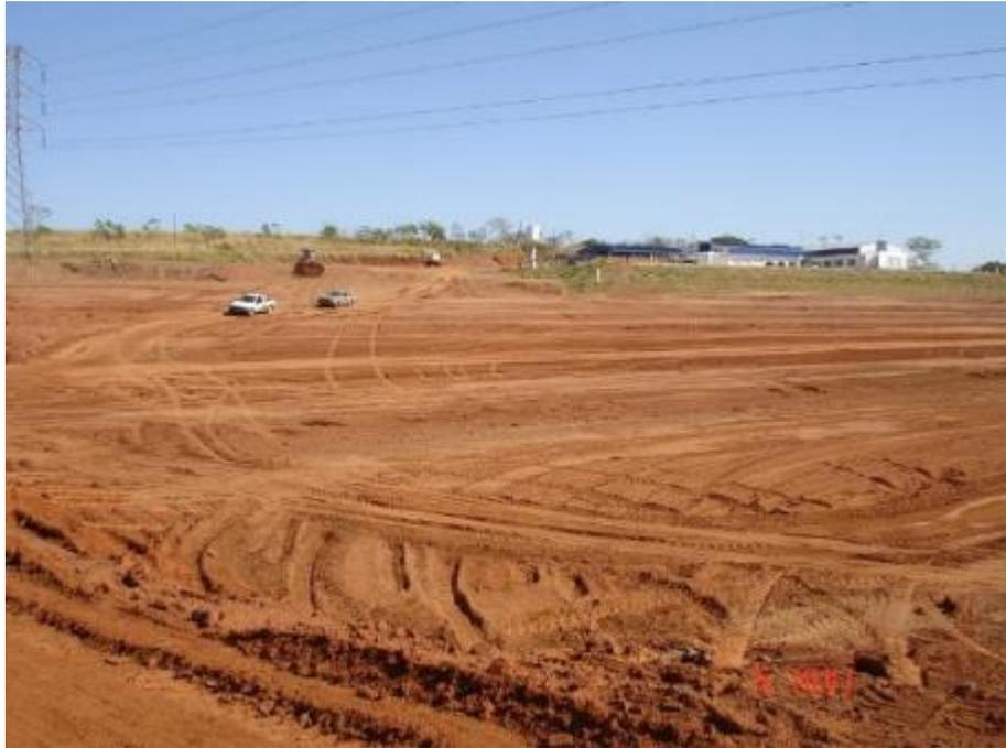
**Figura 46.** Terraplenagem da área de pastagem para início da construção dos viveiros.
