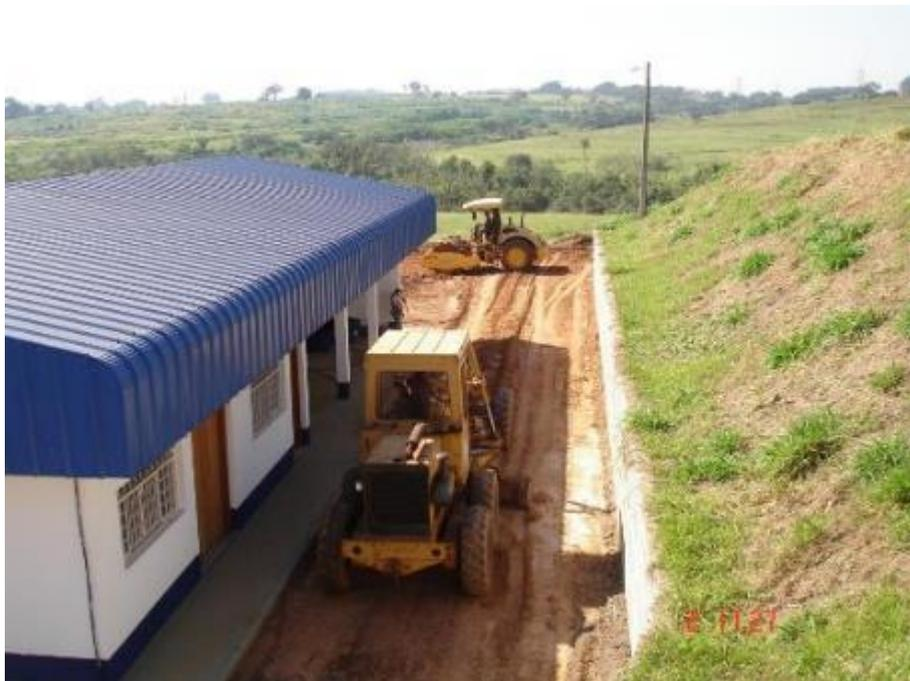
**Figura 40.** Terraplenagem da área ao lado da edificação de manutenção para colocação do piso intertravado.
