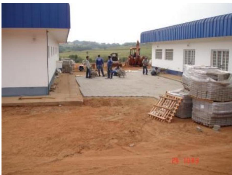
**Figura 42.** Colocação do piso intertravado entre a edificação de manutenção e o Laboratório de Análises de Água "Dra. Margarete Mallasen".
