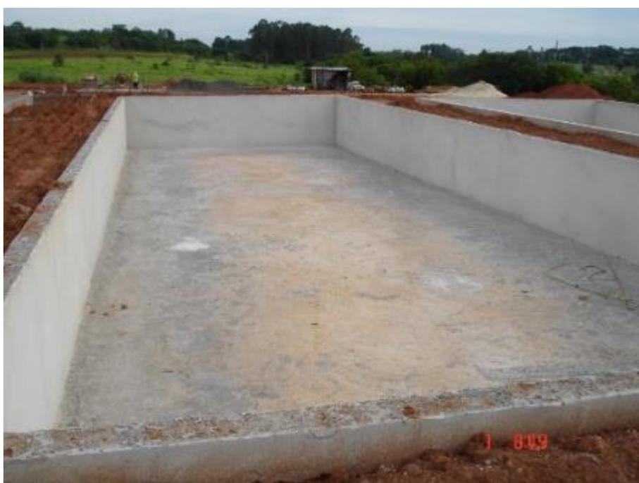
**Figura 49.** Tanques de alvenaria de 200 m<sup>2</sup> (10 unidades), destinados a ensaios com organismos aquáticos e para venda de peixes.
