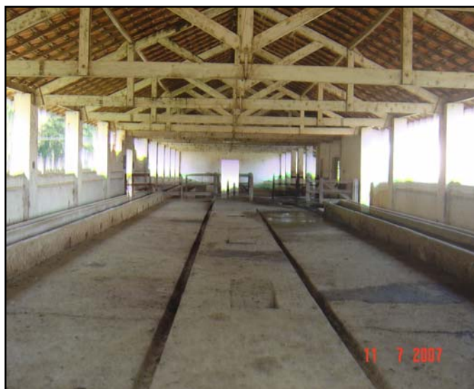
FIGURA 24a. Vista geral do estábulo localizado próximo à Represa do Borba
