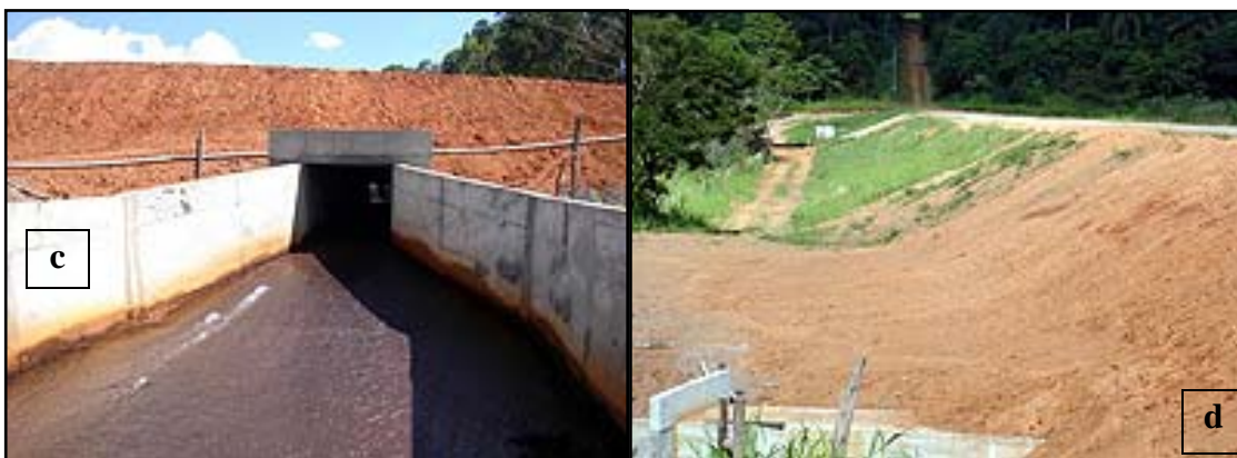
FIGURA 21c. Canal de escoamento da represa.
