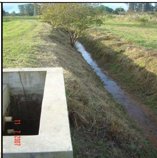
FIGURA 5b. Ponto P3 detalhamento da canaleta de terra com a saída do efluente.
