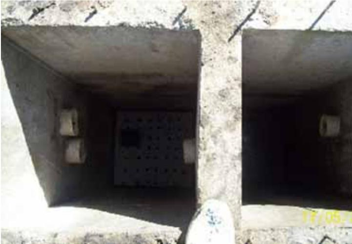
**Figura 5.** Câmaras do filtro anaeróbio em construção, vista superior.
