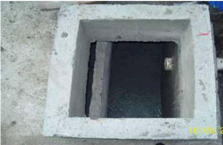
**Figura 3.** Vista superior da caixa coletora do sistema de filtragem anaeróbio da unidade de pesquisa em ranicultura da FIPERJ. Fonte: Roberto Rodrigues de Oliveira (2011)
