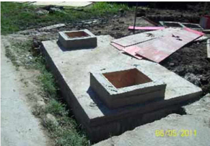
**Figura 4.** Vista superior do tanque séptico em construção. Fonte: Roberto Rodrigues de Oliveira (2011)
